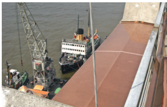
Aufgeklebt und andgedrückt hält das Blech allen Witterungsbedingungen stand.
