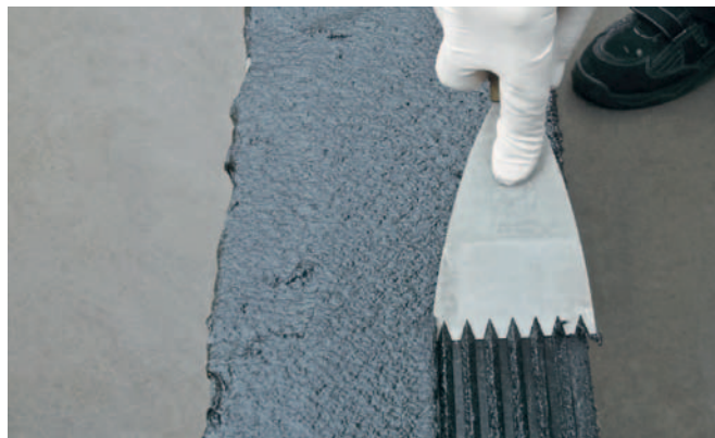
Enkolit® mit dem Rillenspachtel abziehen
